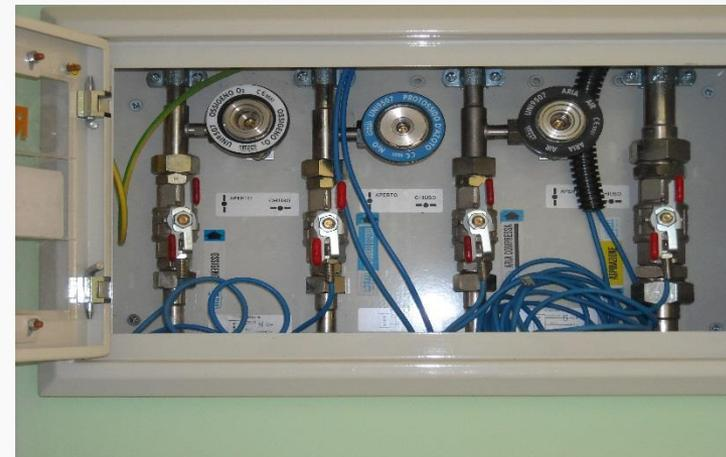
*La struttura dell'impianto prosegue prevedendo una prima "Cassetta valvole intercettazione gas medicinali VVF generale" installata normalmente al piano terra di ogni edificio.*
