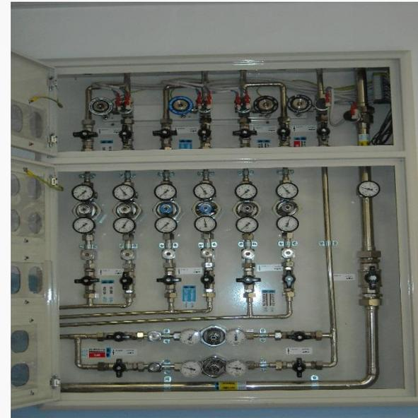
***In reparto è installato il “Quadro di riduzione gas medicali di 2° stadio” nonché una seconda “centralina controllo pressioni gas medicinali”, dotata di tasto di “Reset”. All’interno vi sono valvole di intercettazioni, doppi riduttori di pressione, pressostati di controllo valore pressioni e prese gas “di emergenza”.***
