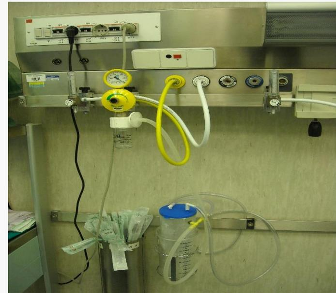
**La distribuzione dei gas medicinali termina alle prese (unità terminali) installate "a muro" e/o sulla trave testata e/o sui pensili in sala operatoria. I gas sono identificati con i seguenti colori (come da normativa vigente):**
